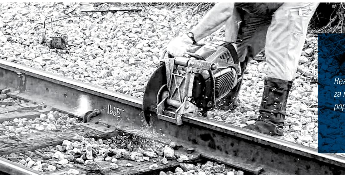
Rezna ploča Metalynx Max za rezanje dela šine za popravku.
