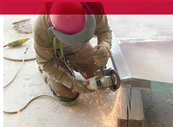
Desbaste de una plataforma como preparación para soldadura.
